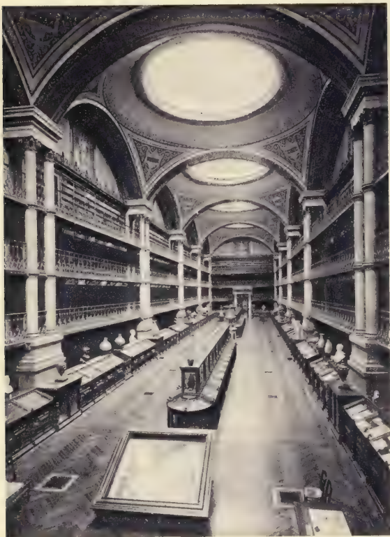
Grande salle de la Bibliothèque.
